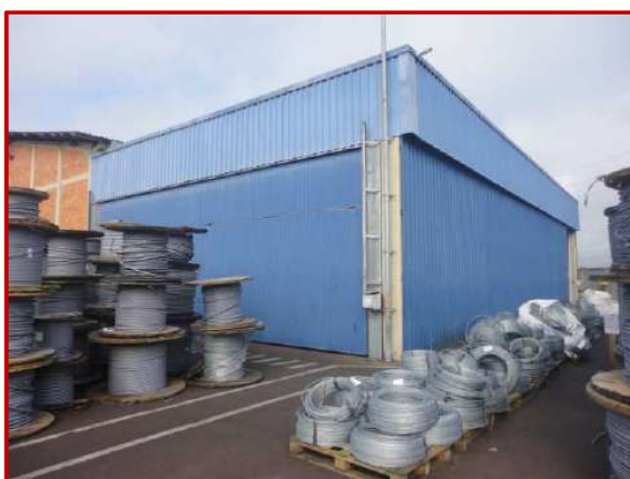
Vista Externa do Depósito
