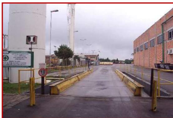
Plataforma da Balança Rodoviária e Reservatório em Concreto com Capacidade para 50.000 litros
