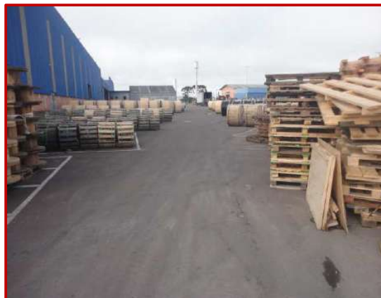
Pavimentação Asfáltica do Pátio
