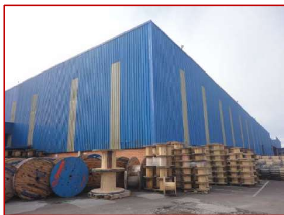
Vista Externa do Estoque / Separação
