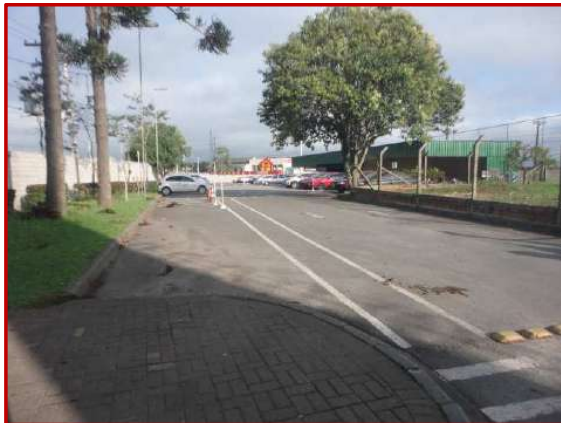
Pavimentação Asfáltica do Estacionamento
